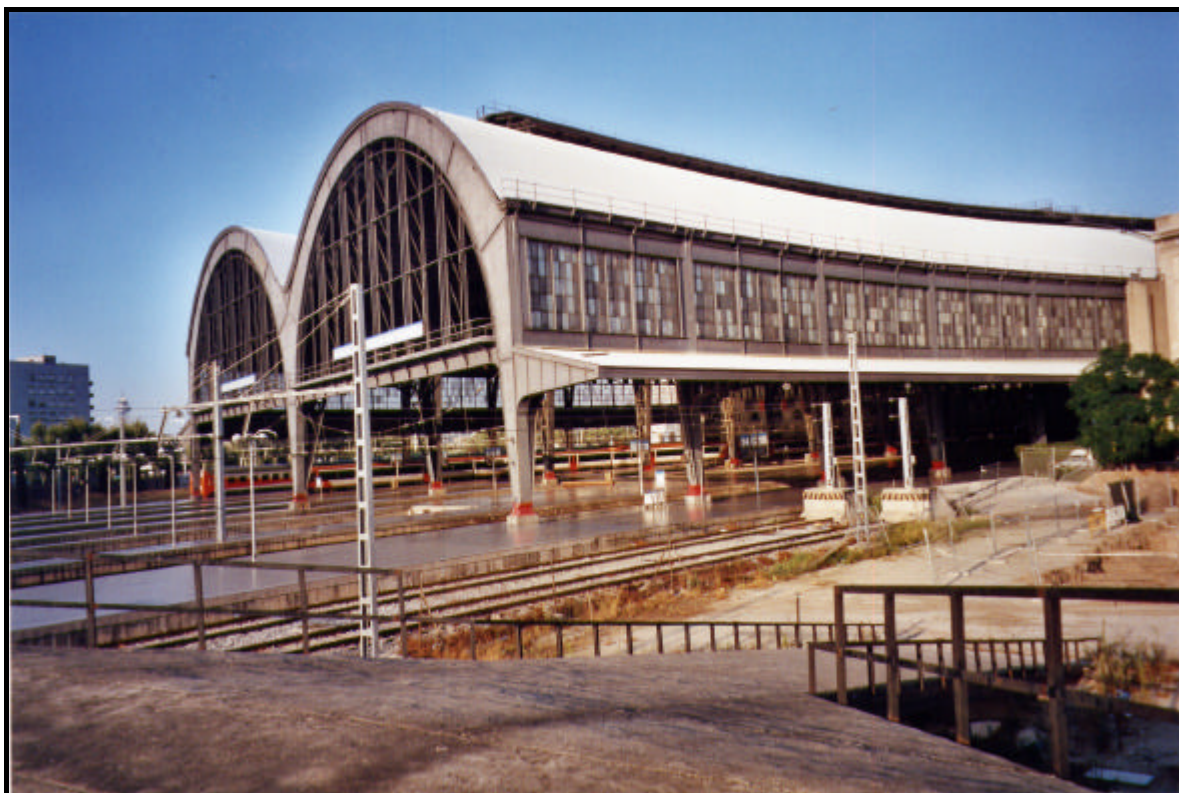
1. Foto general de situació on es veu la façana nord-est de l'Estació de França
