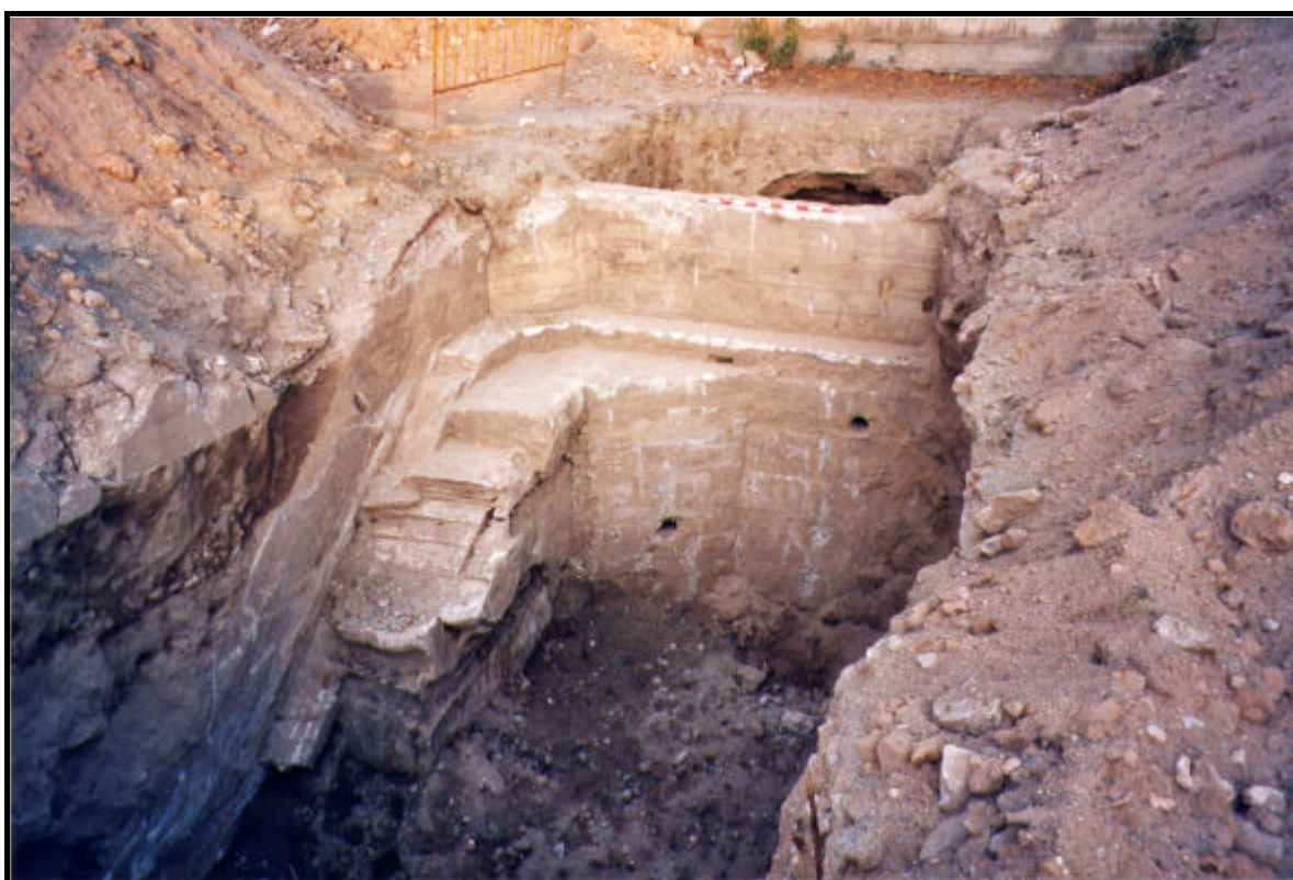
16. Detall de les parets de formigó localitzades a l'interior de la RASA 3
