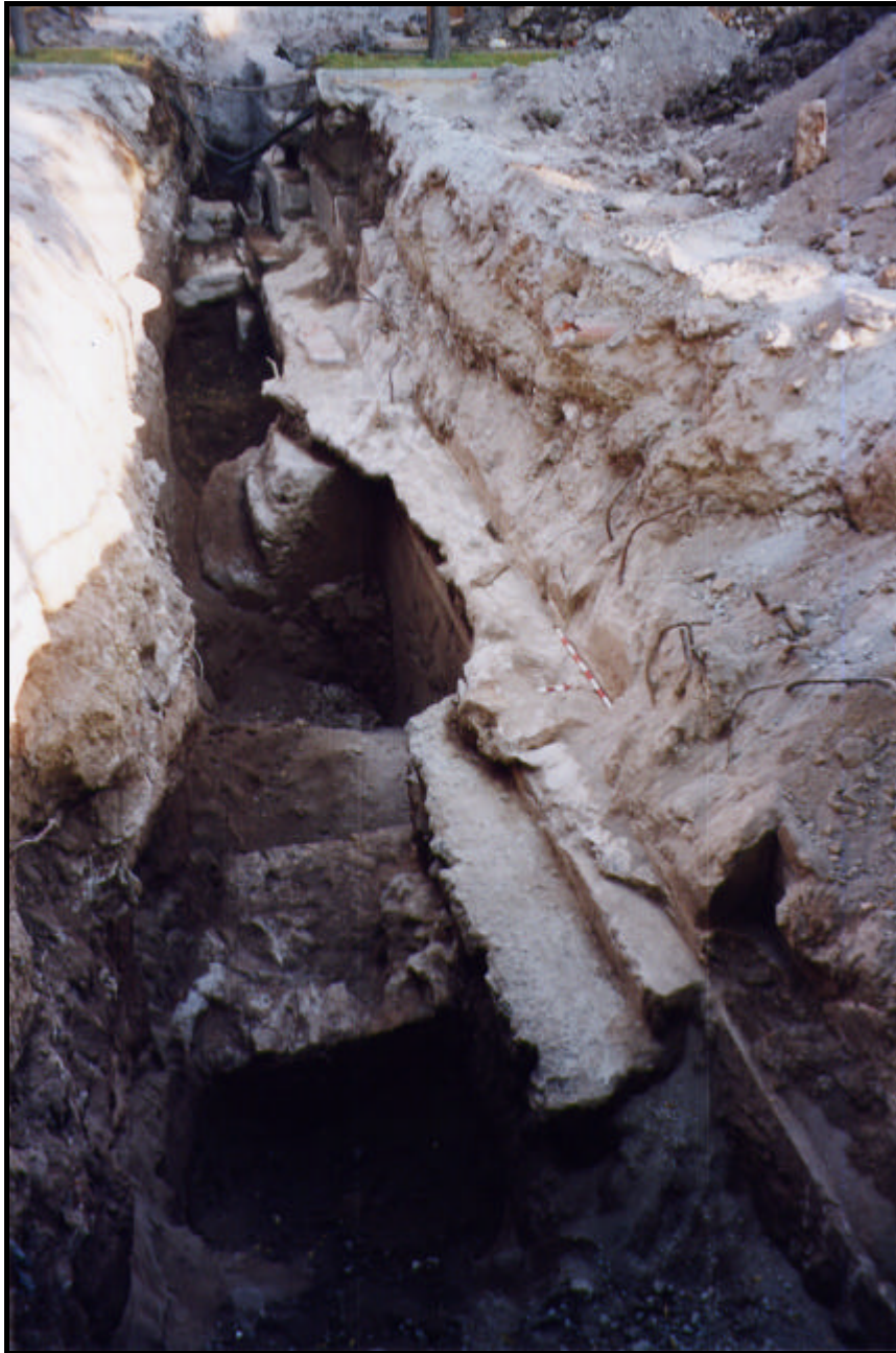
4. Vista de la RASA 1 un cop excavada, on es veu l'estructura de formigó (U.E 102) i la part superficial del mur U.E 104
