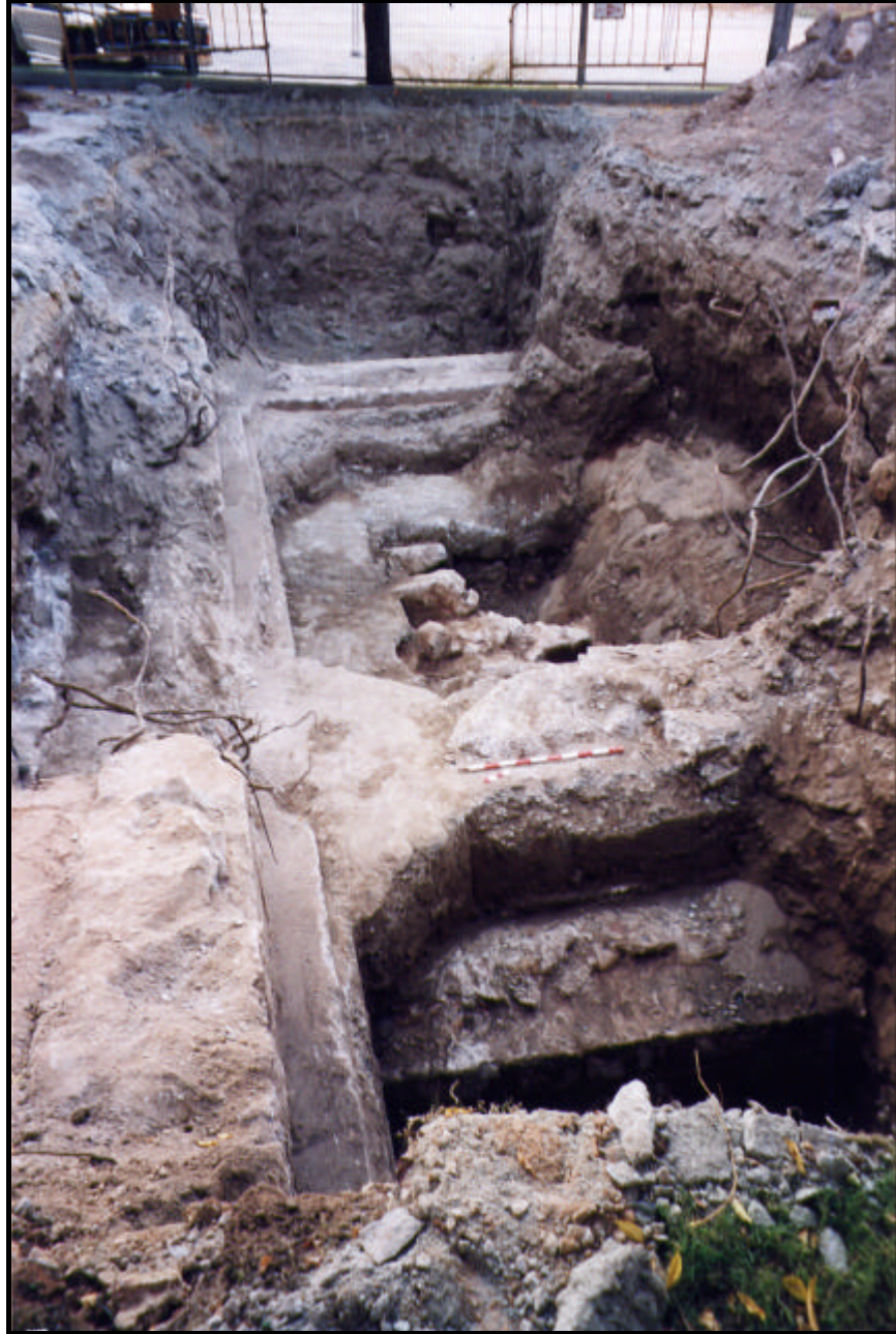
11. Vista general de la RASA 2, des de l'oest, un cop excavada, on s'hi observa l'estructura de formigó U.E 202
