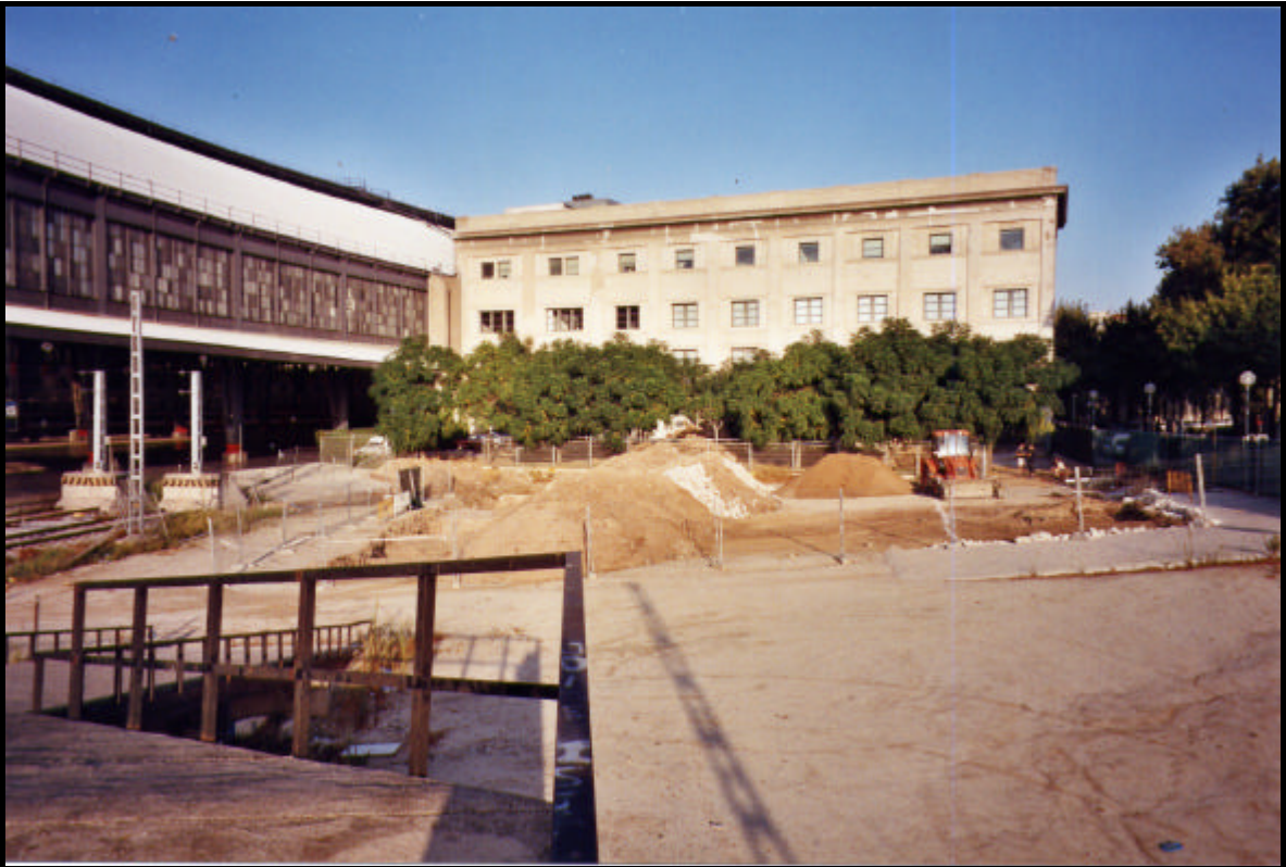
2. Vista general de l'indret on s'ha treballat, al fons es veu l'edifici de la UPF
